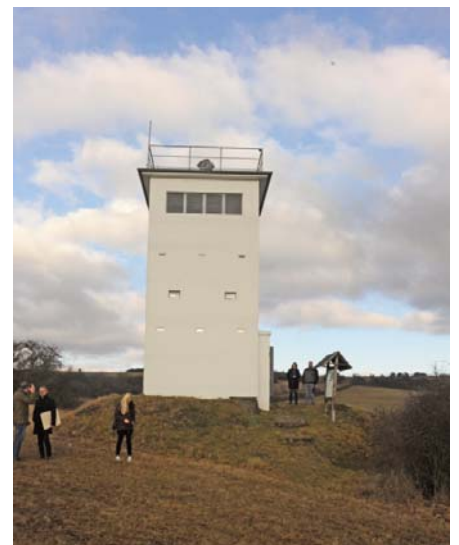
Die bauliche Sanierung des ehemaligen Grenzturms ist abgeschlossen. Nun wird die Ausstellung installiert.
